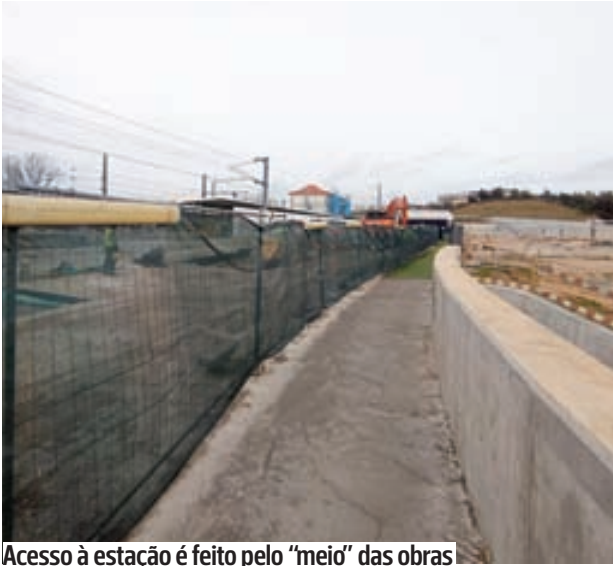
Acesso à estação é feito pelo “meio” das obras
